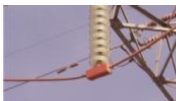
图 13 绝缘护套现场安装图
